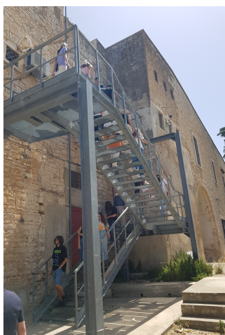
Scala esterna di emergenza.
